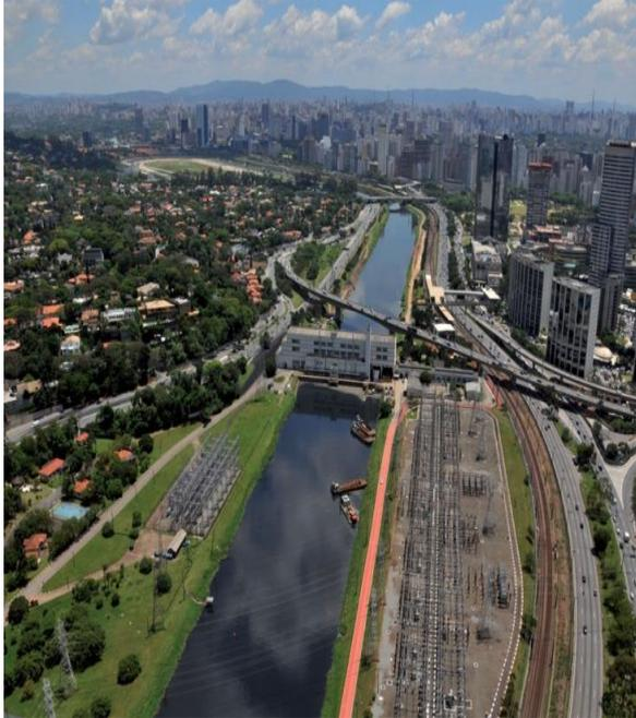
**Características:** o canal possui um comprimento total de cerca de 25 Km, com uma largura aproximada de 80 metros e profundidade média de cerca de 3 metros e sua bacia hidrográfica é de 277,1 km<sup>2</sup>
