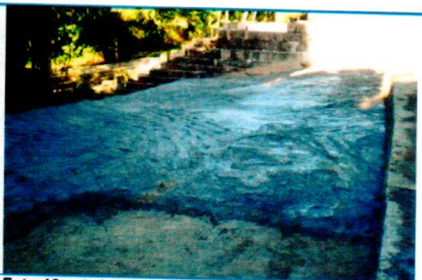
Foto 12 – Junho de 2009. Vista geral da área após preenchimento total com concreto.
