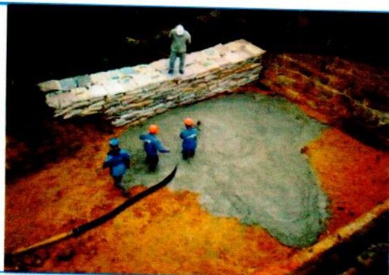
Foto 11 – Junho de 2009. Lançamento do Concreto com Resistência Característica Compressão (fck) 18 Mpa.
