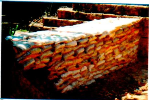
Foto 10 – Abril de 2009. Contenção com solo cimento ensacado, conhecido como Rip-Rap.
