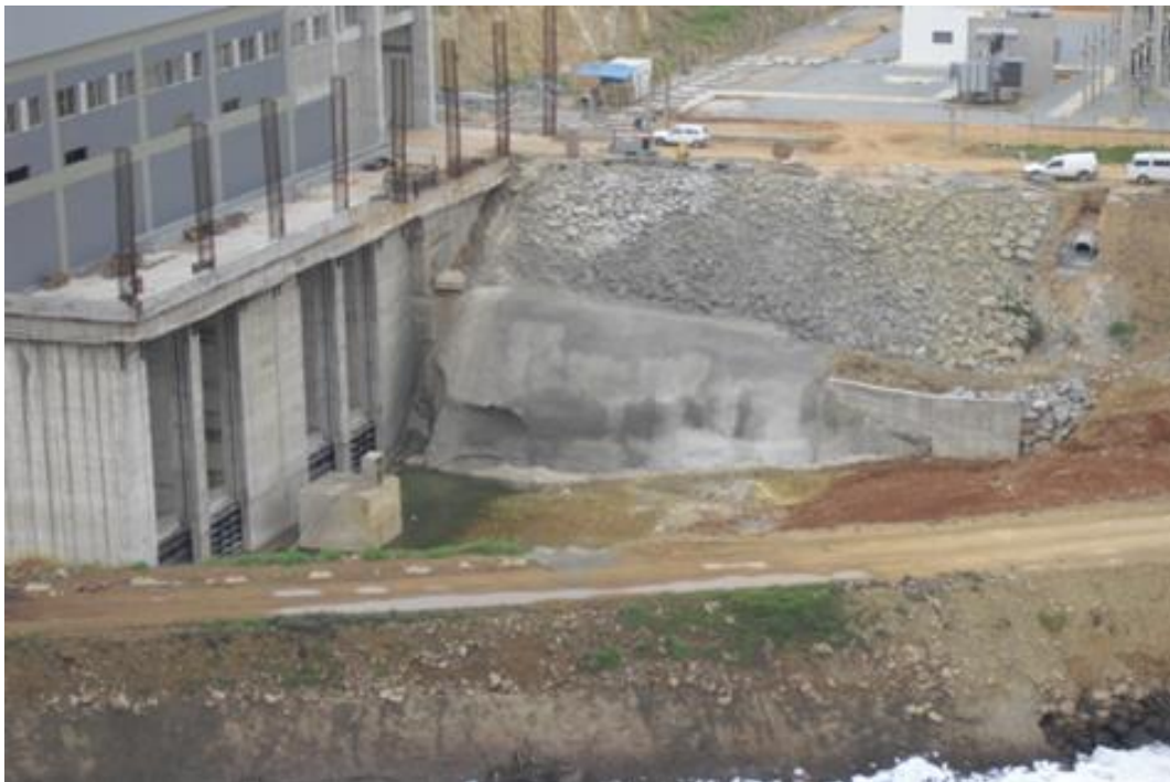
Proteção do talude
