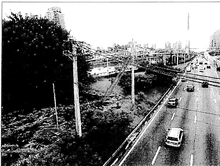
Fotografia 1: Vista da frente da área voltada p/ Marginal do rio Pinheiros.
