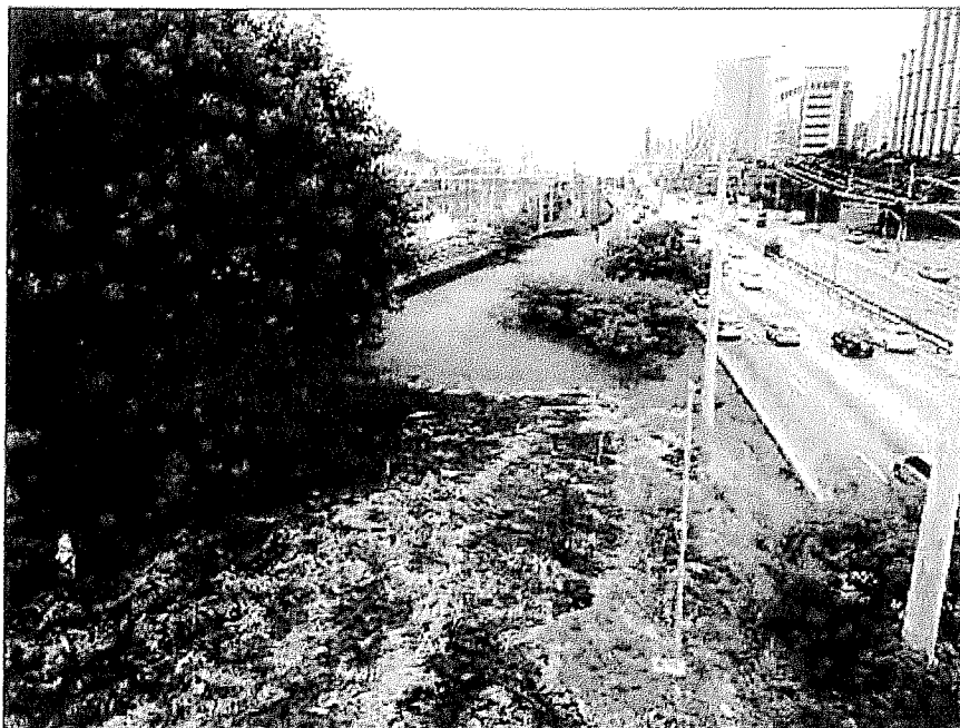
Fotografia 3: Vista da área triangular, foto tirada da Ponte do Morumbi.
