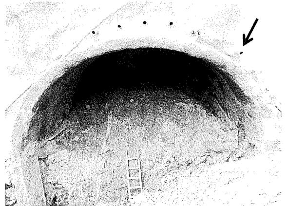
**Figura 04 – Execução de enfilagem com processo de perfuração, revestimento simultâneo e Injeção de argamassa no solo sob pressão;**
