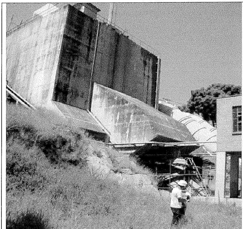
Local do posicionamento do guindaste de 400 Ton e a altura de içamento do pistão e da comporta.
