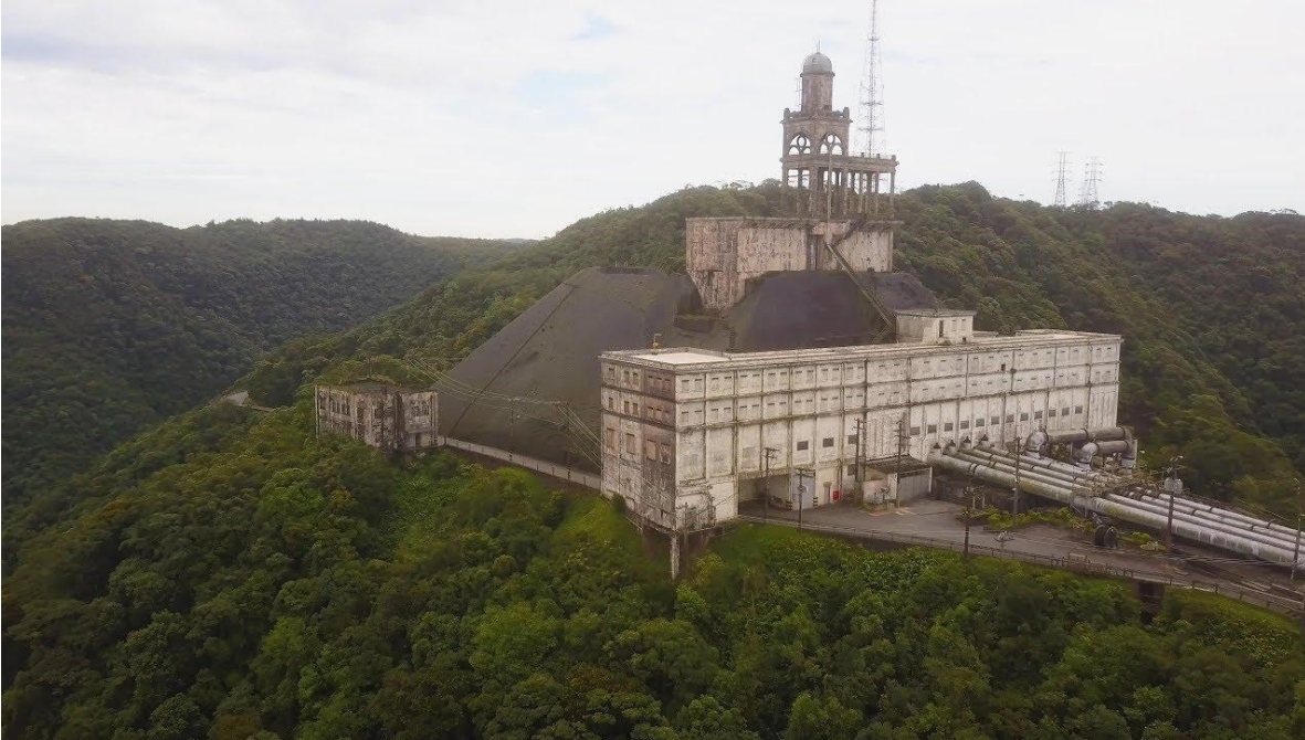
Figura 1.3 – Casa das Válvulas
