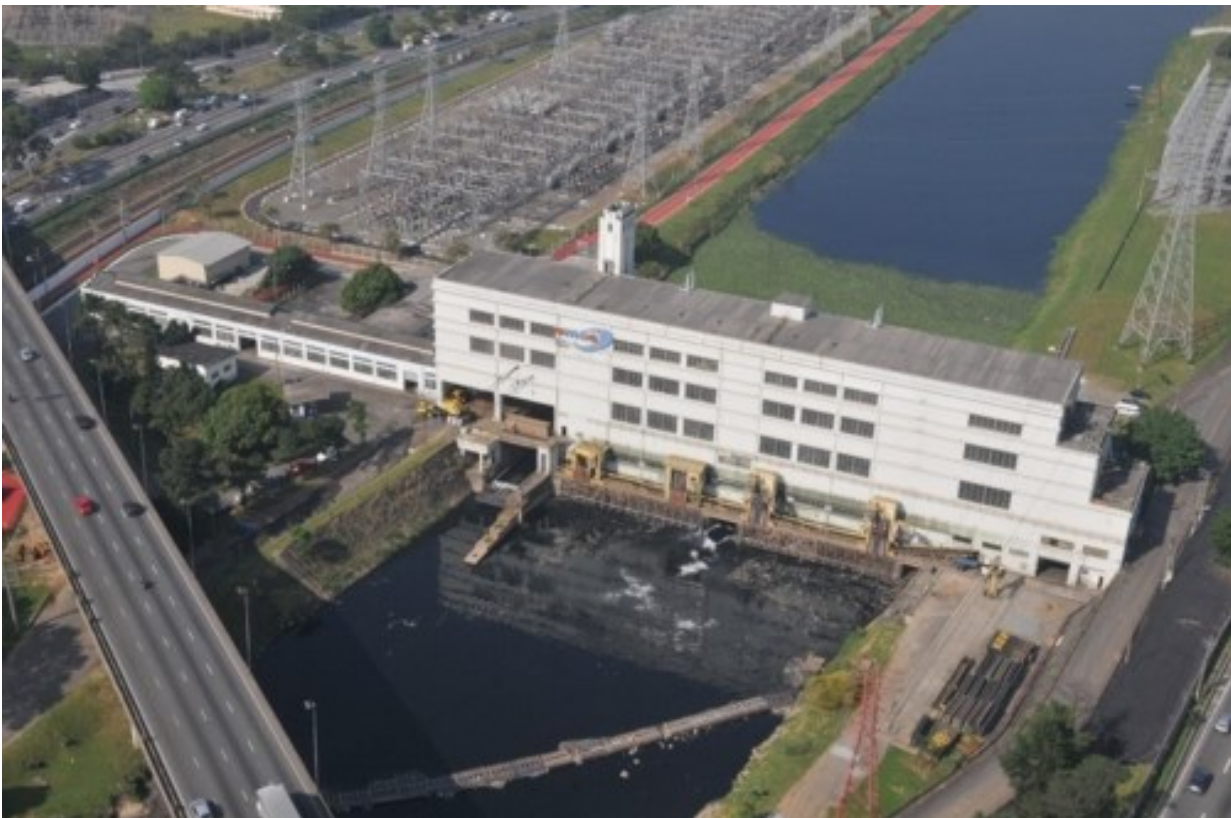
Figura 1.2 – Usina Elevatória São Paulo
